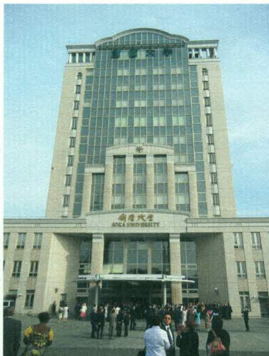
Torre principal en el campus de la Universidad Soka
