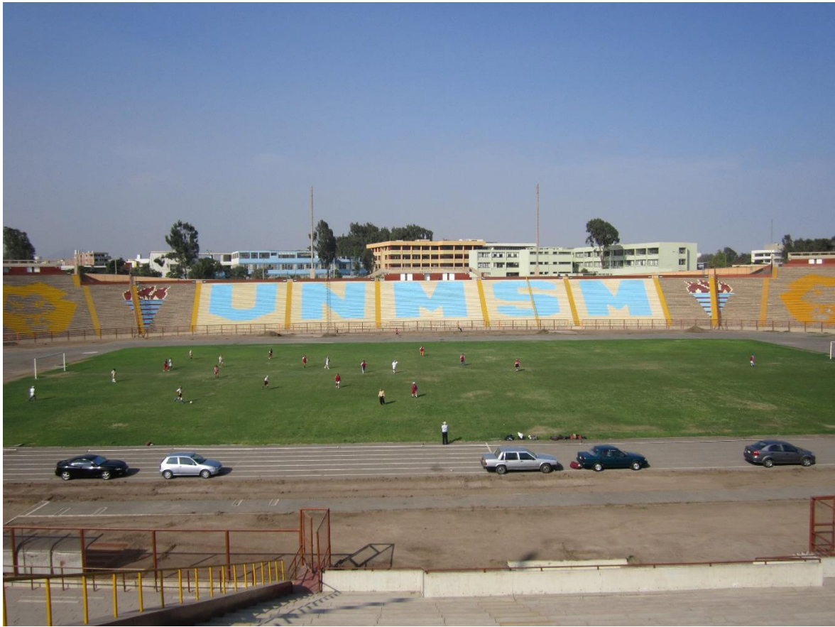
VISTA GENERAL PISTA ATLETICA Y CAMPODEPORTIVO
